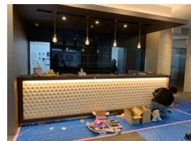
ホテルカウンター造作家具工事
